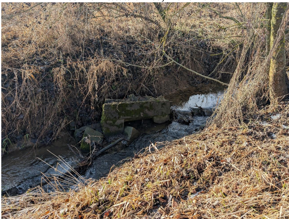
Obr. Sesunutě obetonování meliorační výustě
