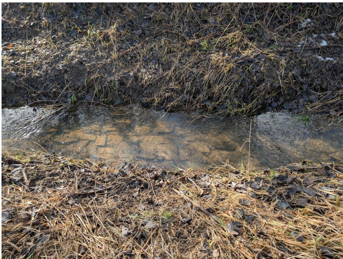
Obr. Horní část toku – zde již kámen na štět
