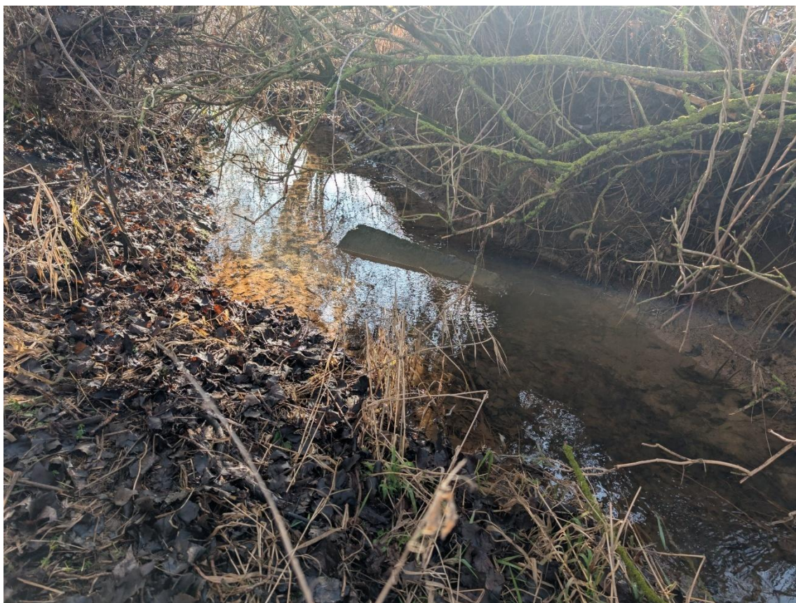
Obr. Betonové tvárnice v korytě toku, již nedrží lichoběžníkový profil
